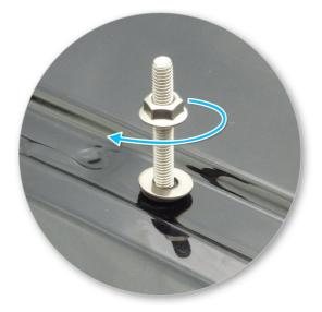
• Screw flange nut onto hex bolt.
